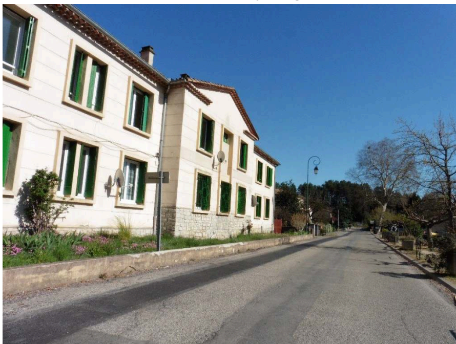
Photographie 2 : L'ancienne gendarmerie de Lasalle, support pour le dispositif CAO et l'accueil des huit majeurs afghans
