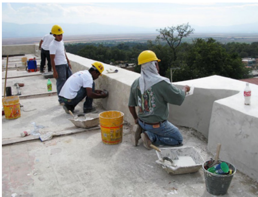
FIGURA 4. OBREROS TRABAJANDO EN LA AZOTEA DEL TEMPLO
