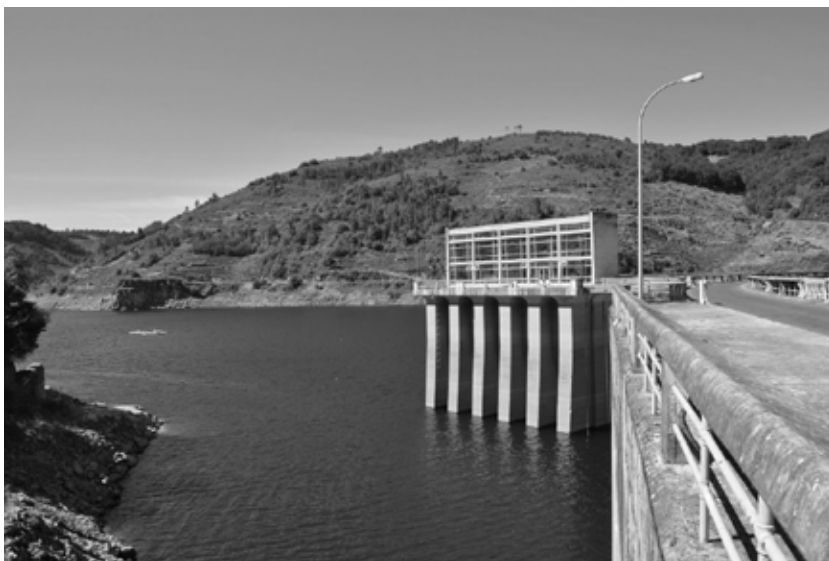
FIGURA 4. EDIFICIO DE LA SUBESTACIÓN DE BELESAR
