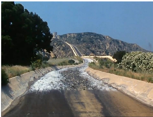
L'aqueduc de Los Angeles, premier plan de Los , James Benning, 2001
