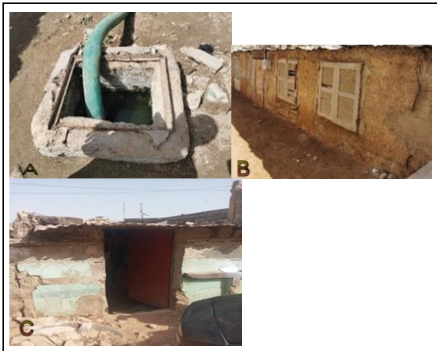
Fig. 5 : Etat des bâtiments et du niveau de la nappe dans la commune de Djiddah Thiaroye Kao
