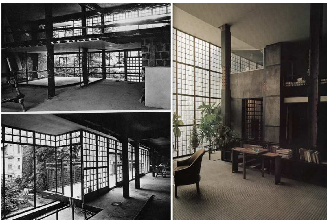
Document n°31 : maison de verre. Architecte : Pierre Chareau (cf. Pierre Chareau. Architecte-meublier... ).
